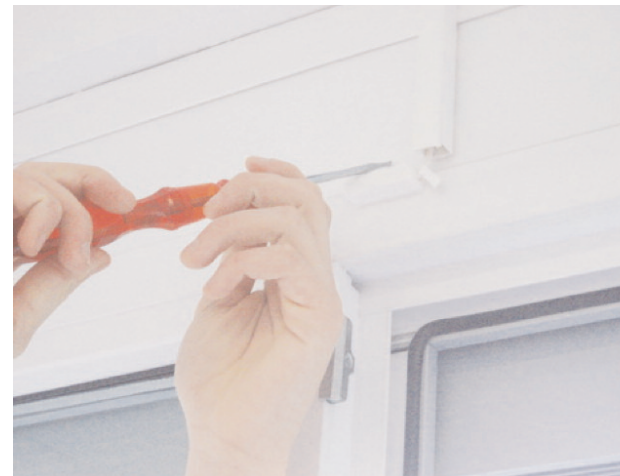
Die mittels Magnet betätigten Reedsensoren signalisieren der Steuerung, dass ein Fenster geöffnet ist.
